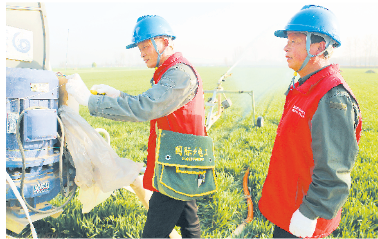
近日,国网太康县供电公司组织焦裕禄共产党员服务队到农田机井供电设施进行检修维护,保障群众春耕用电安全。记者张洪涛 通讯员 邱志强 摄
